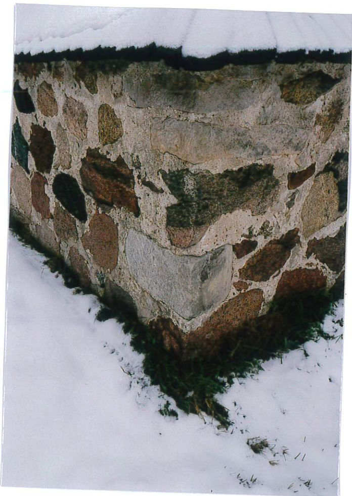
Fot. 3. Podmurówka - narożnik południowo-zachodni.
