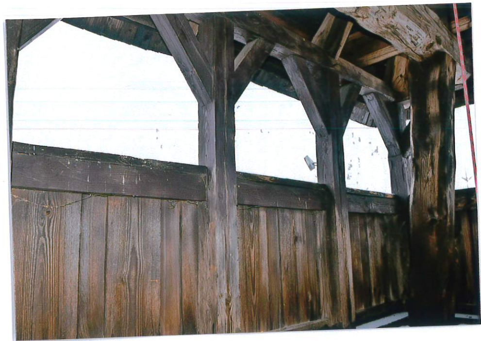
Fot. 10. Konstrukcja słupowa na piętrze z dzwonami.
