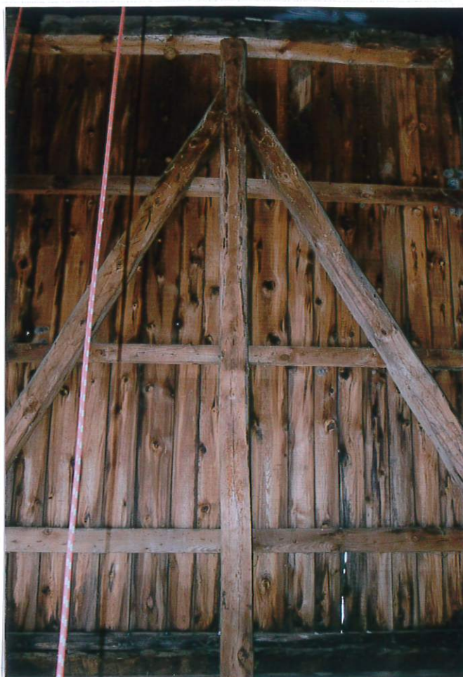
Fot. 7. Ściana południowa.
